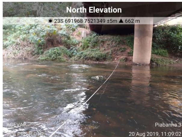
Ponto 3 – detalhe da trena
