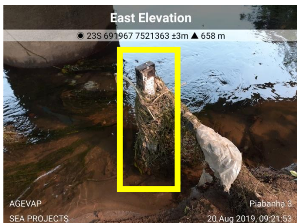
Ponto 3 – régua de nível antes da limpeza
