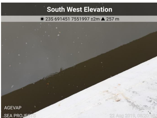
Ponto 8 – detalhe para espuma e flutuantes
