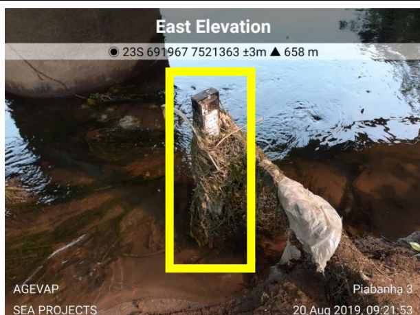
Ponto 3 – régua de nível antes da limpeza
