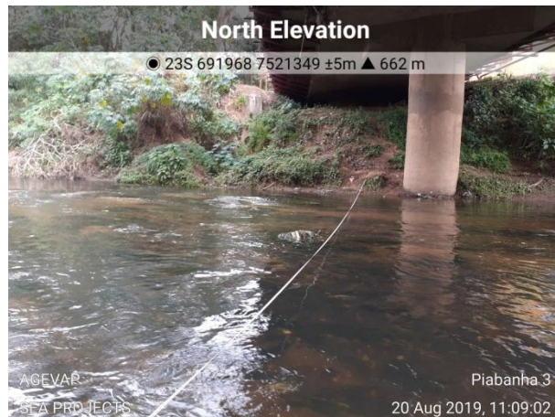
Ponto 3 – detalhe da trena
