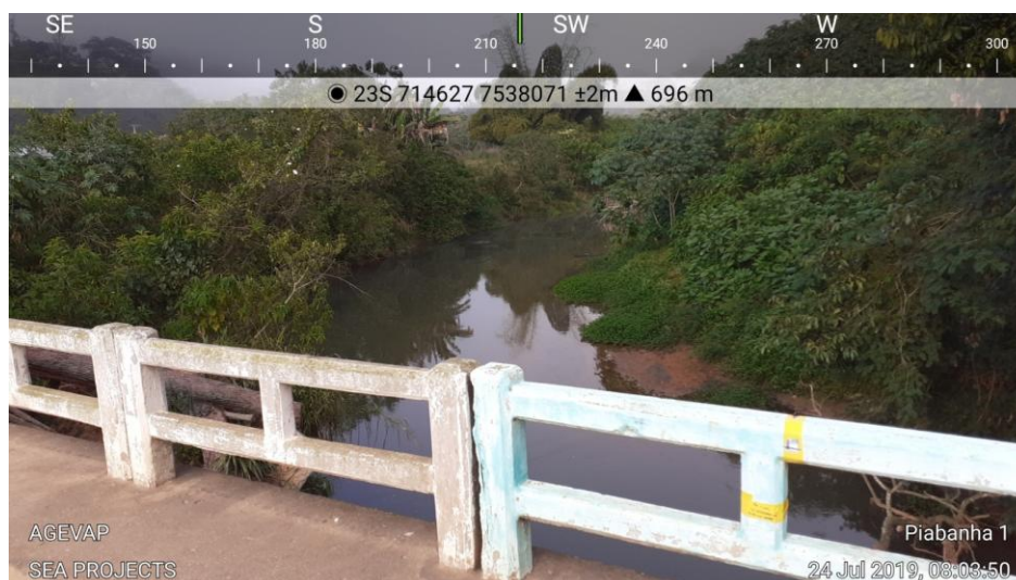
Figura 3.1-29: Visada para montante da estação controle – Ponto 9.
